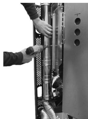
Fig. 64 - Fissaggio tubo
