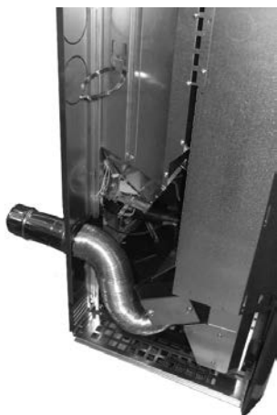
Fig. 58 - Posizionamento tubi per canalizzazione posteriore
