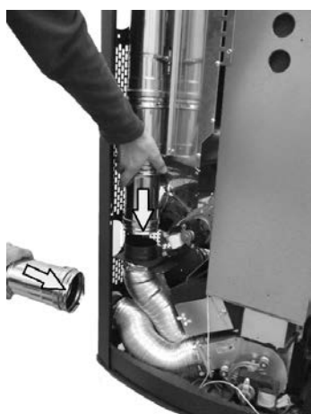
Fig. 63 - Posizionamento tubi per canalizzazione
