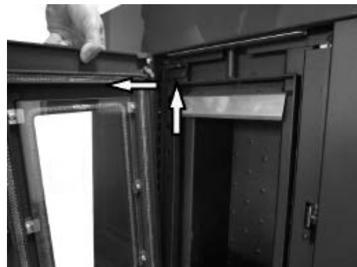
Fig. 53 - Rimozione porta
