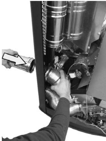
Fig. 66 - Posizionamento tubi per canalizzazione
