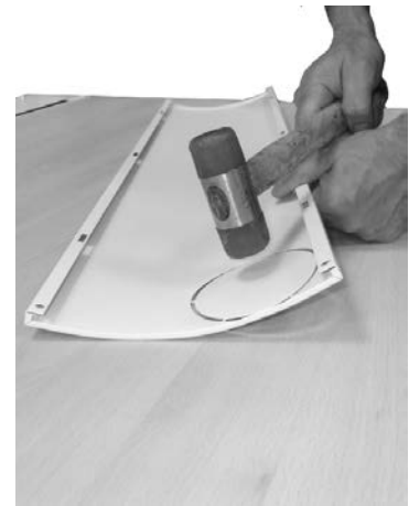
Fig. 38 - Apertura foro (modello Sfera 3 Plus)
