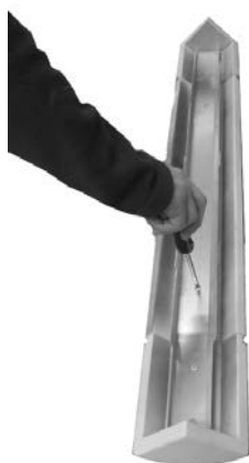
Fig. 34 - Avvitare profilo alle maioliche
