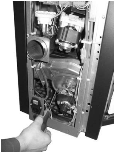
Fig. 104 - Pulizia aspiratore fumi: fase 1
